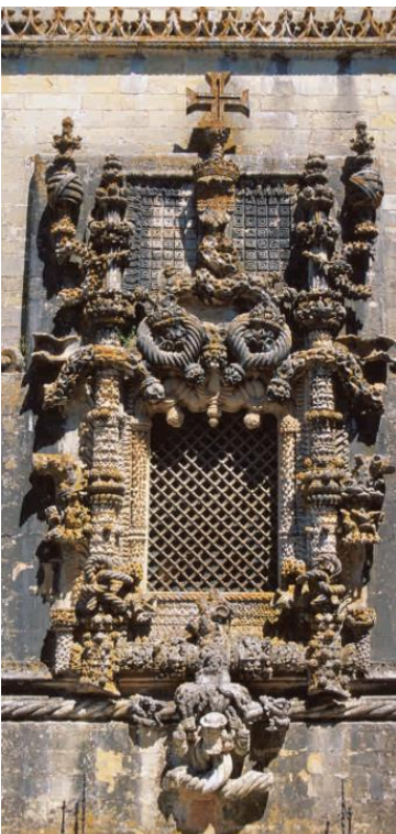
Janela da Sala do Capítulo do Convento de Cristo, em Tomar.
